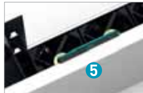
5 Nasadte kryt zpět na radiátor, ale bez mřížky. Umístěte ovládání na přední panel.
